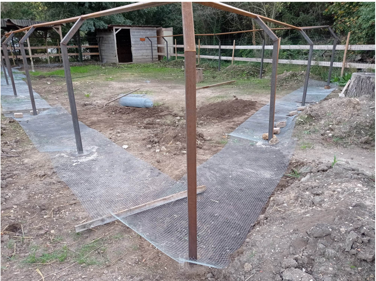
Figure 9: Enclos en construction: pose du grillage de bordure
