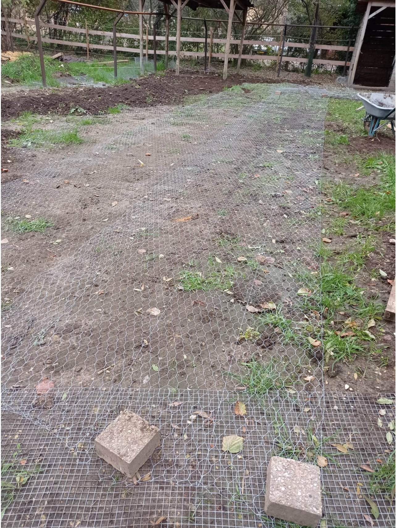
Figure 12: Sol entièrement grillagé, avec recouvrement. Le grillage est enterré
